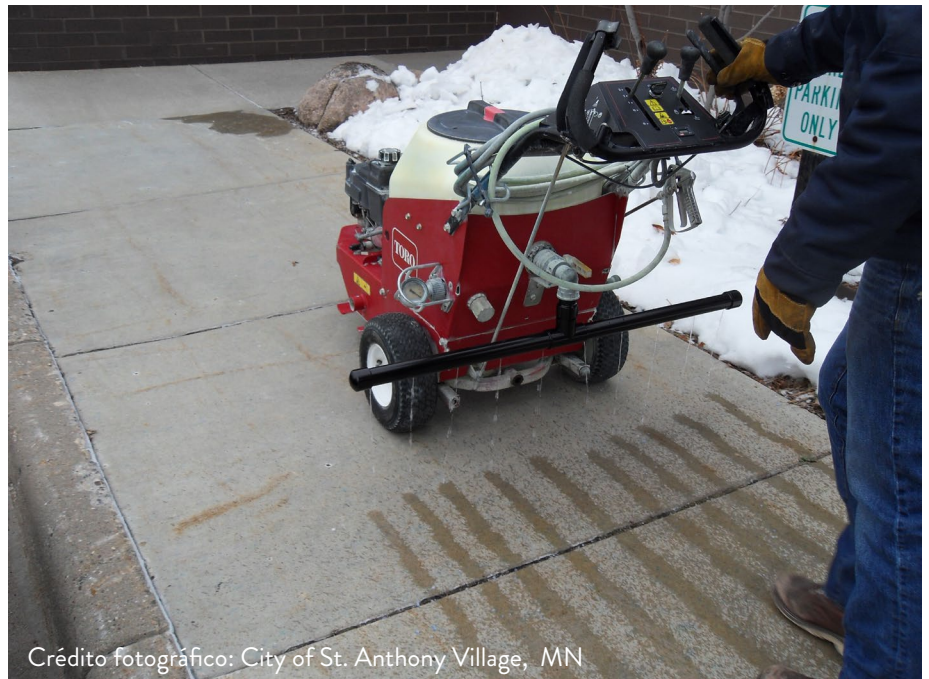
Figura 22: Patrón húmedo/seco de aplicación preventiva.
