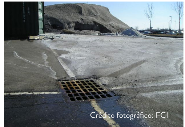
Figura 12: Almacenamiento incorrecto de sal: sin cubrir y colocado en la trayectoria del deshielo de una pila de nieve.
